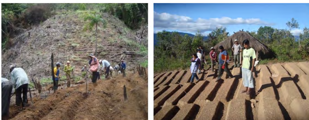
Foto 19. Construcción de wachos, sanjeo
