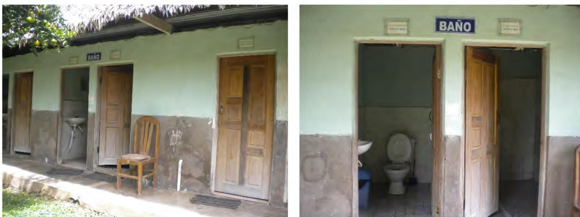
Foto 3. Batería de baños y lavamanos
