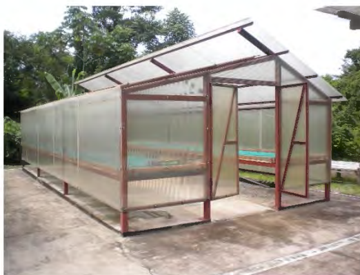
FOTO 12. SECADORA SOLAR CON CUBIERTA
